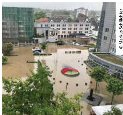
Extremersituation in Eschweiler: Das Wasser der Inde zerstörte die beiden Untergeschosse des St. Antonius Hospitals komplett.
